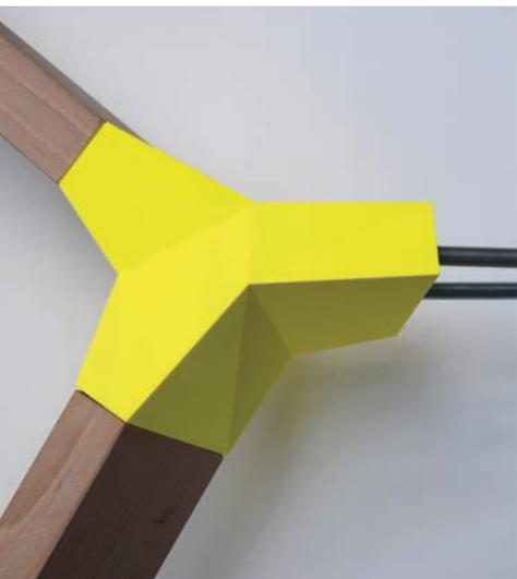
Abb. 8: Formkörper mit 3D-Druck als verlorene Schalung
