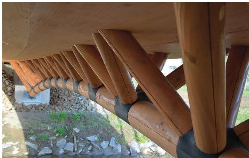
Abb. 5: Brückentragwerk aus Rundholz
