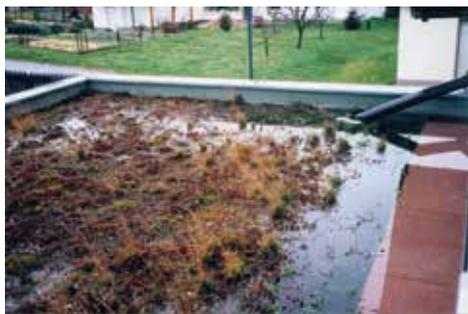
Abb. 2: Gründach am 20.02.99 nach rund 8 mm Niederschlag in ca. 3 Stunden (rechts im Bild der Zufluss vom Steildach)
