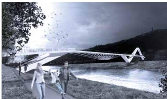
Abb. 4: Irminensteg Trier – Sprengwerk / Hängewerk: Perspektive vom Moselradweg [Loiko/Wark 2014]
