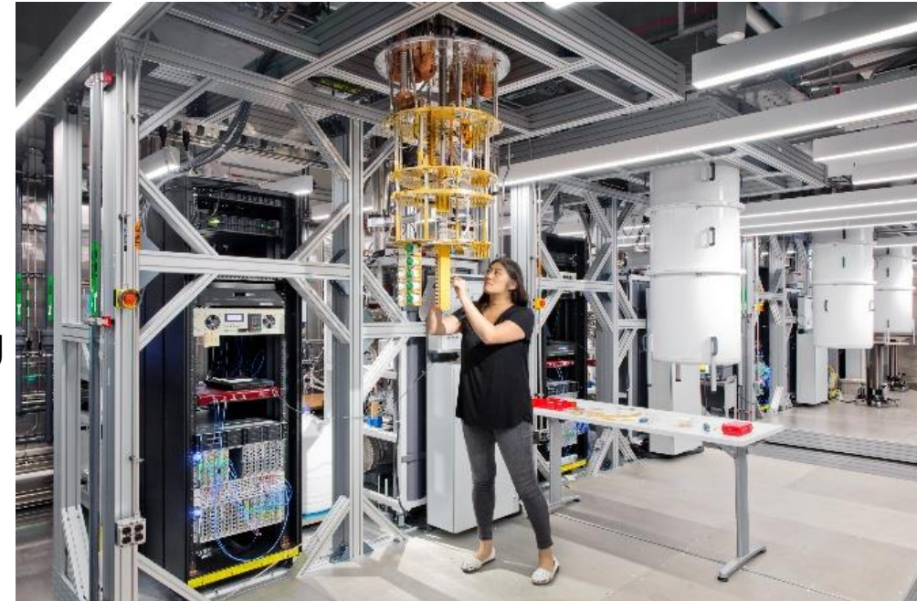
Aktueller IBM Quantencomputer Bildquelle: IBM
