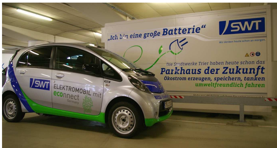
Bild: : Foto der Redox-Flow-Batterie „Cellcube FB 10-100“ im City-Parkhaus
