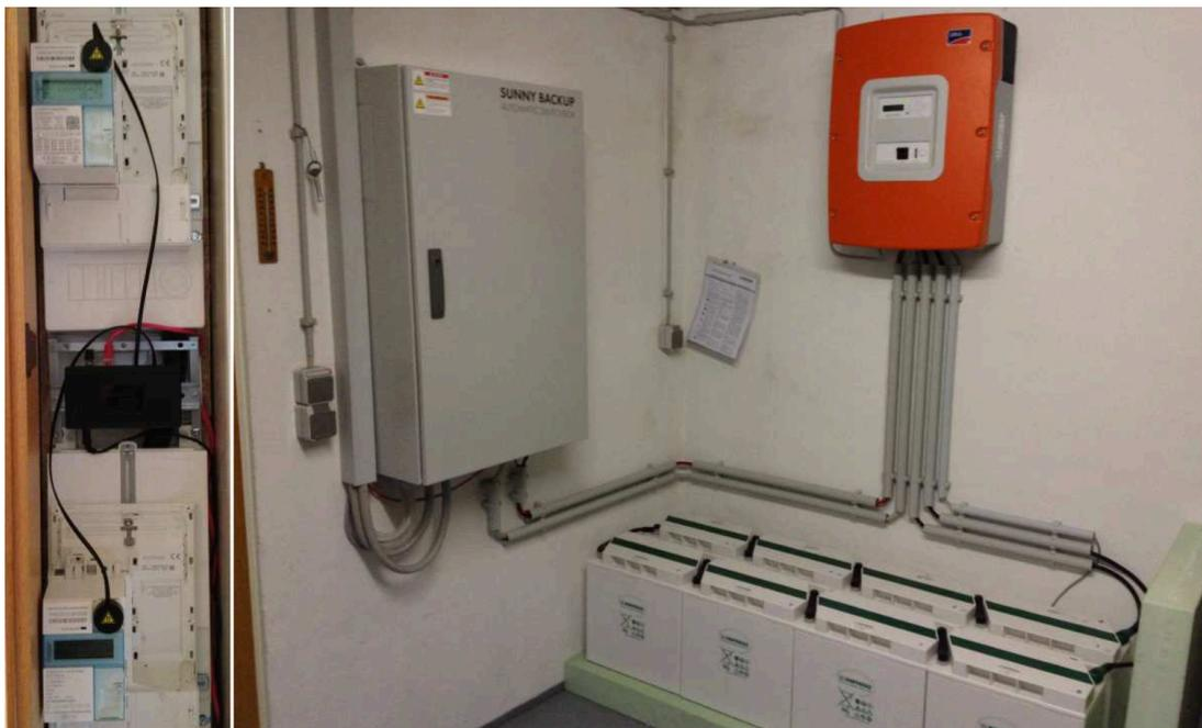
Bild: Backupsystem des Objekts, links MeterBox, mitte SwitchBox, rechts SBU5000
