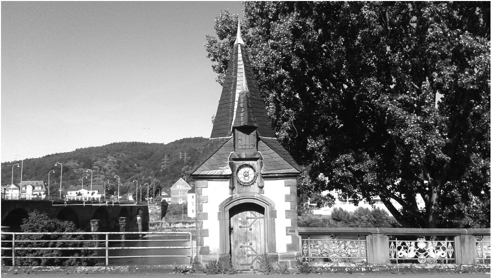
Abb. 1: Pegelhäuschen Römerbrücke (Aufnahme vom 23.6.20).
