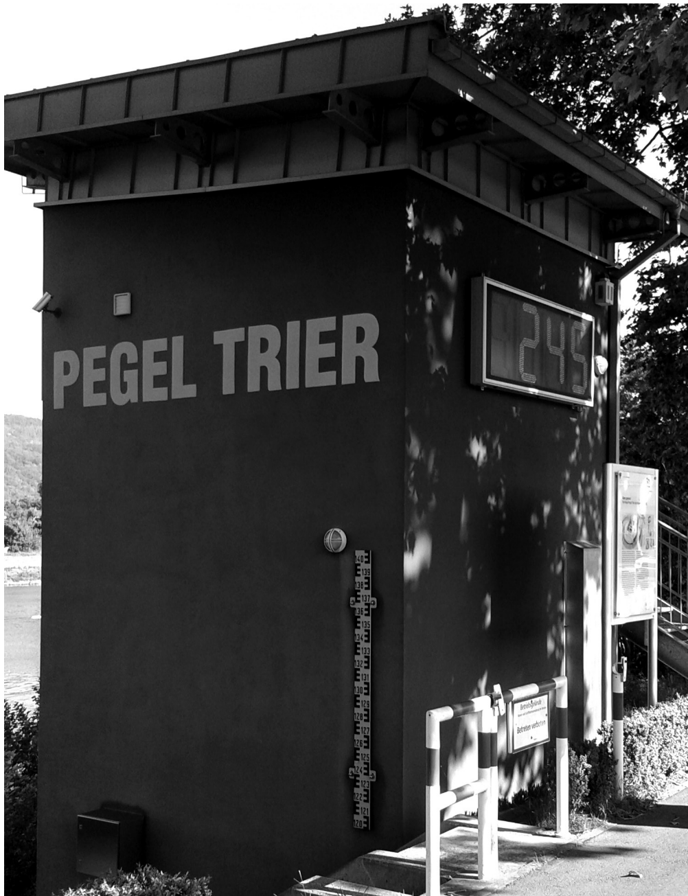
Abb. 8: Der neue Pegel UP Trier mit Pegellatte (oberste Staffel) und Wasserstandanzeige (Aufnahme vom 23.6.20).
