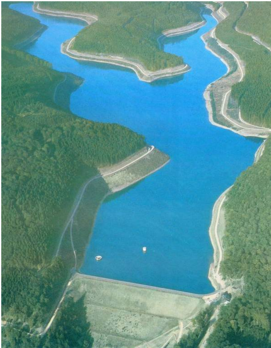
Bild 5: Primstalsperre im Hunsrück
