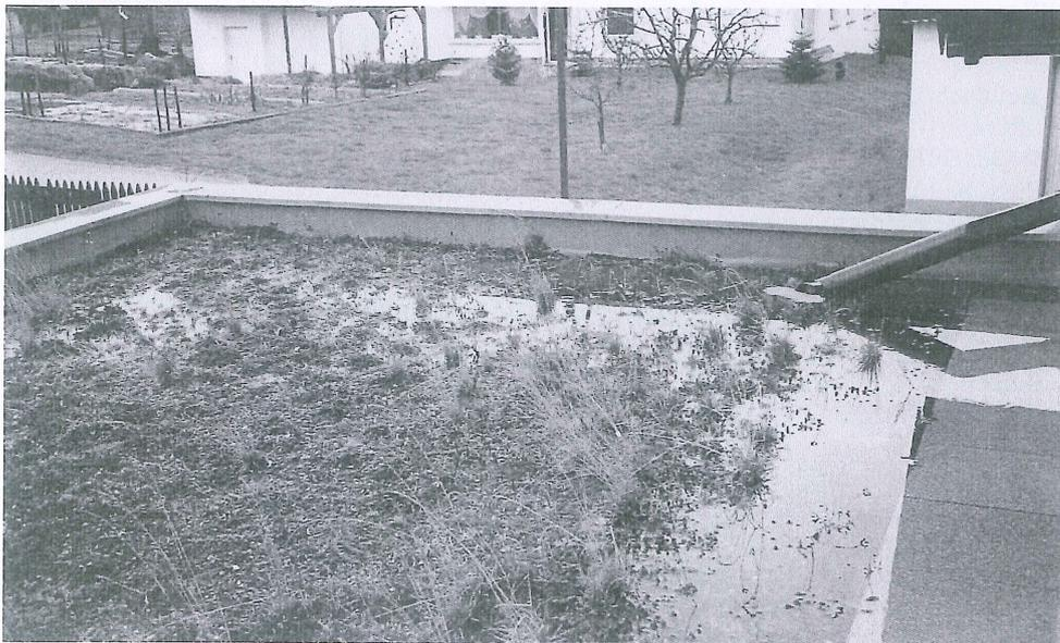
Bild 6: Gründach am 20.02.99 nach rund 8 mm Niederschlag in ca. 3 Stunden (rechts im Bild der Zufluss vom Steildach)
