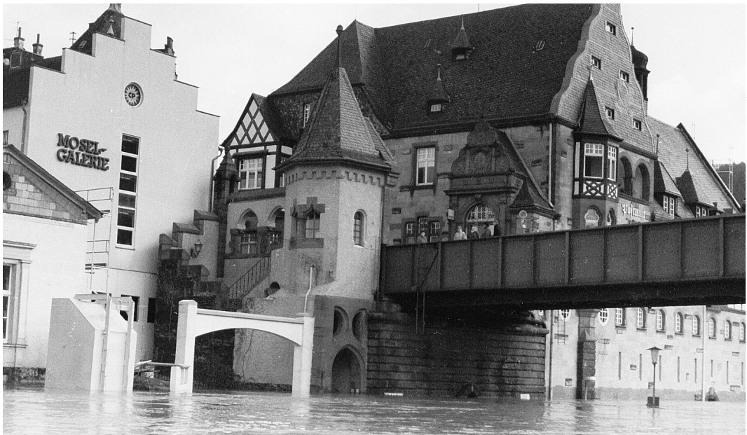
Dezemberhochwasser 1993. Gesamtansicht des Pegelstandorts Traben.
