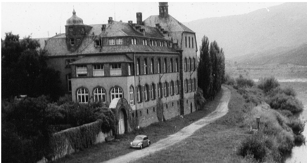
Gesamtansticht des Pegelstandorts Kues
