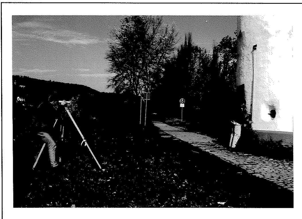
Abbildung 6 Bei den Vermessungsarbeiten
