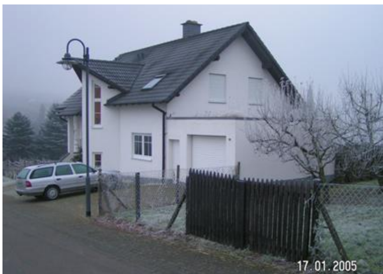
Bild 6: Gesamtansicht (im Vordergrund Garage mit Gründach)
