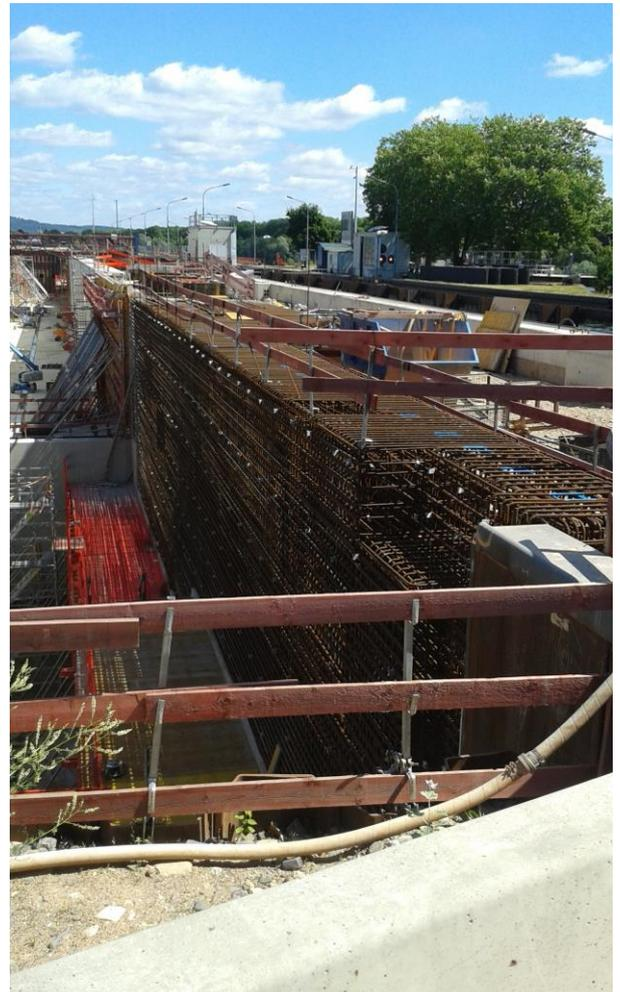
**Schleusenbaugrube mit viel Stahlbewehrung, insbesondere zur Rissbreitenbeschränkung**
