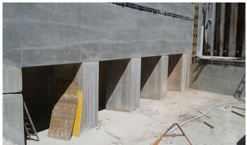
Auslaufbauwerk der Längskanäle zum Entleeren
