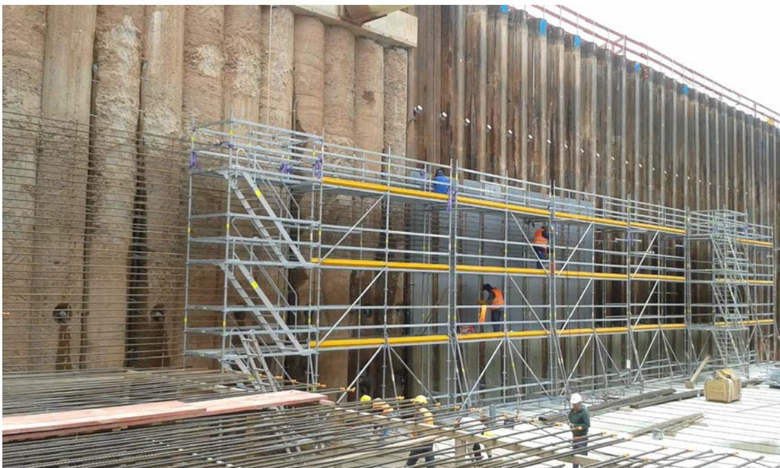
links Bohrpfehlwand, rechts (rückverankerte) Spundwand
