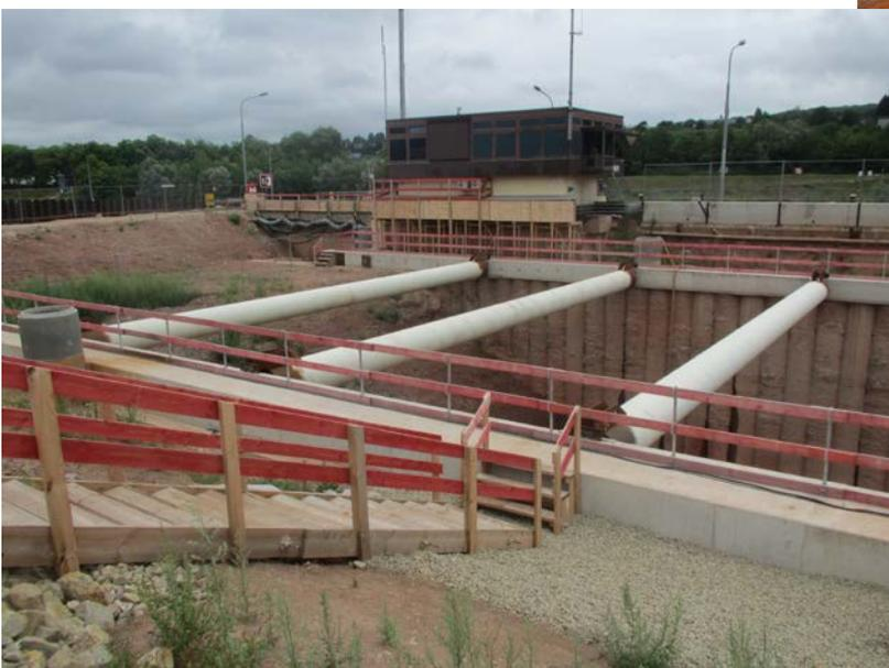
**Baugrube der Schleusenkammer mit temporärer Aussteifung**
