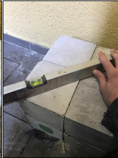
Abb. 7.4: Ausrichtung des Filterunterbaus
