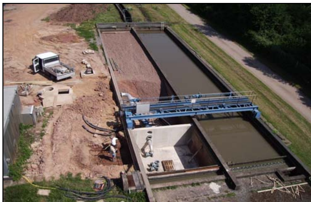
Bild 1 „ehemalige 2-Straßige Vorklä rung“ [3]
